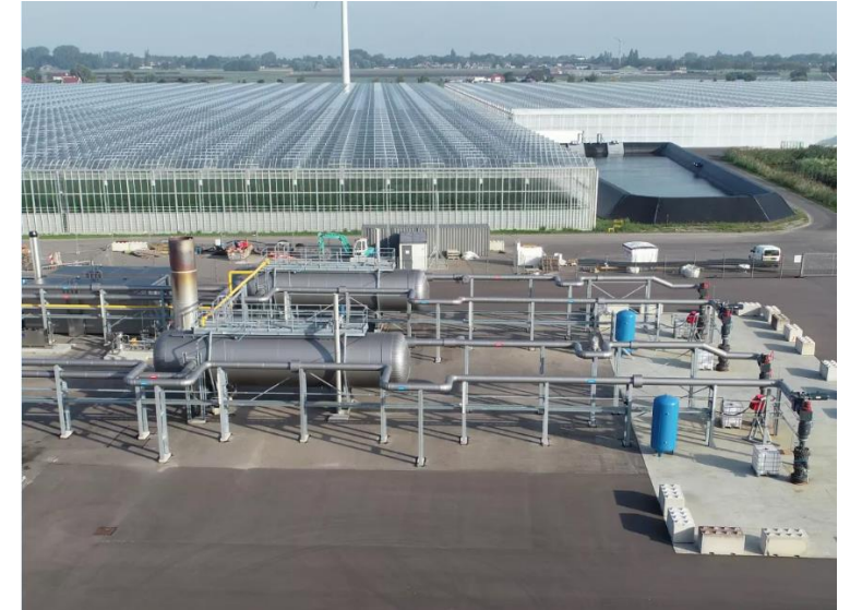
Figuur 7: Geothermie centrale bij tuinders 1 .
