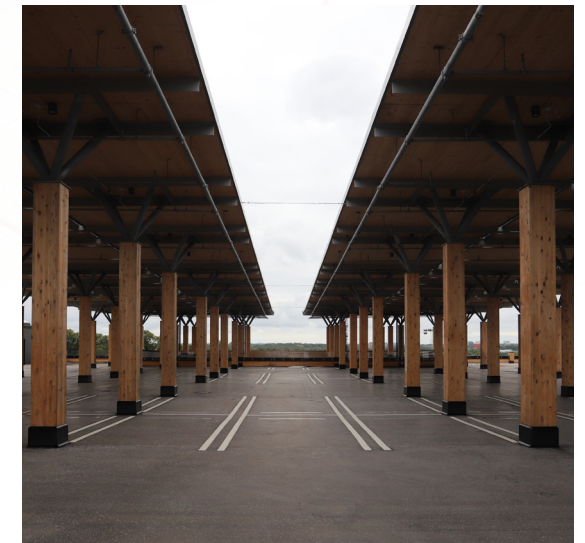
Zonnedak op houten parkeergarage Sege Park, Malmö, Zweden
