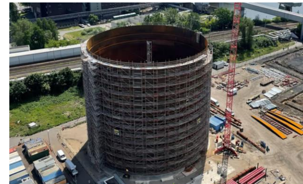
Figuur 14: Warmwatertank in aanbouw in Berlijn 4 .
