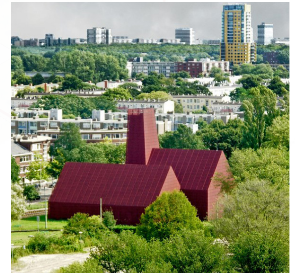
warmteoverdrachtcentrale Haagse Aardwarmte Leyweg, ontwerp: Splinter Architecten b.v
