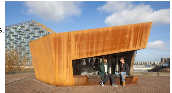
Figuur 16: Warmte overdracht station op Steigereiland, Amsterdam 2 .
